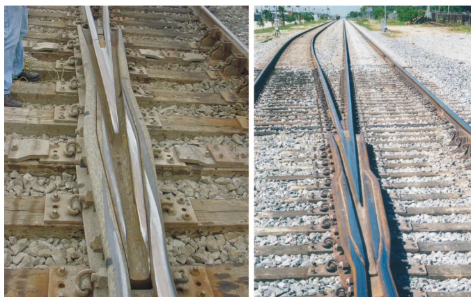
Рис. 6. Стрелочные переводы (производитель – фирма Rail Products, США, Вакуум-процесс)
