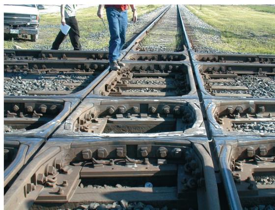
Рис. 7. Отливка «Крестовина» (производитель – фирма Rail Products, Вакуум-процесс)
