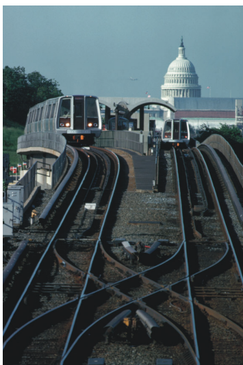
Рис. 1. Стрелочный железнодорожный перевод с крестовиной
