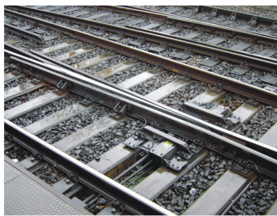
Рис. 2. Литые железнодорожные стрелочные переводы
